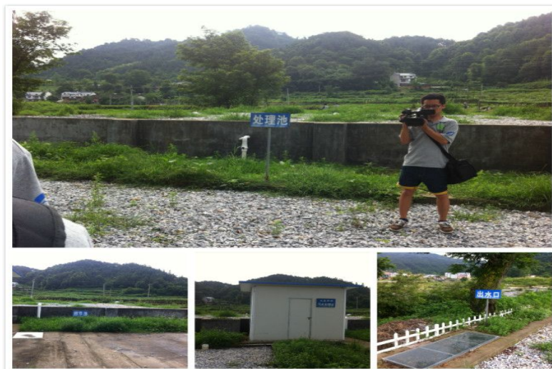
天堂寨污水处理站
